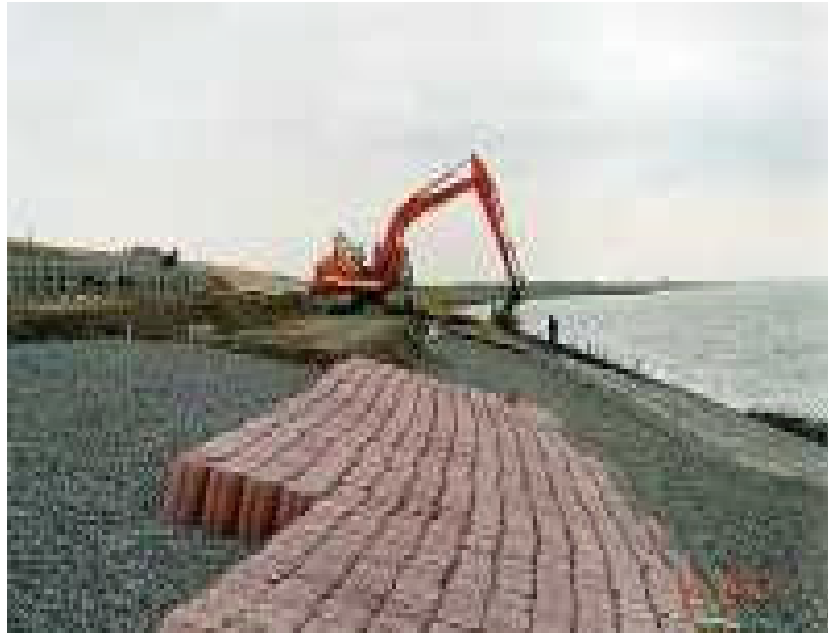
Gambar 7.1 - Contoh tanggul laut dengan armor concrete block (tahap konstruksi)
