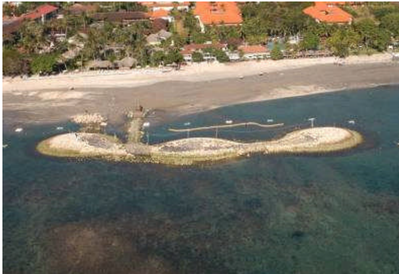
Gambar 7.6 - Contoh pemecah gelombang di Pantai Kuta, Bali (tahap konstruksi)
