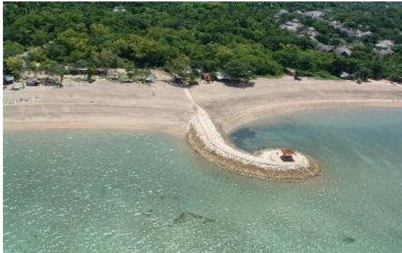
Gambar 7.5 - Contoh krib lengkung di Pantai Sanur, Bali
