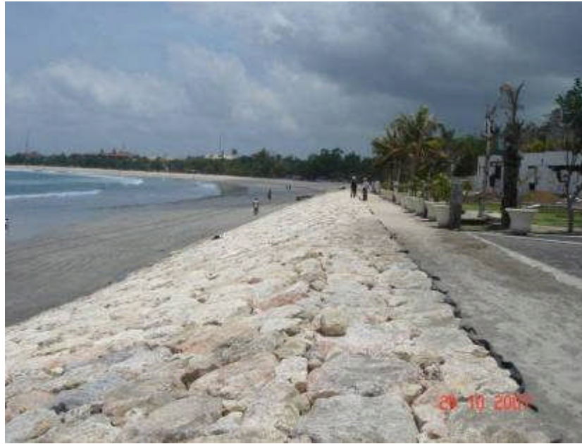
Gambar 7.3 - Contoh revetmen di Pantai Kuta Bali
