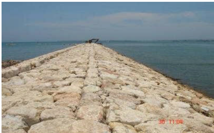
Gambar 7.4 - Contoh krib lurus di Pantai Kuta Bali
