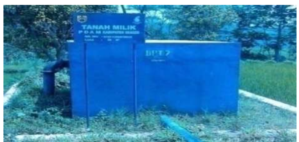
Gambar 3.14 Bak Pelepas Tekan (BPT)
