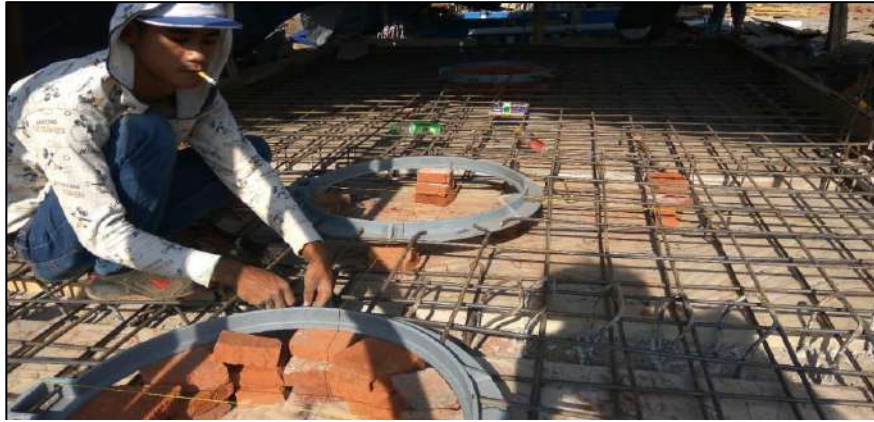
Gambar 4.40 Ilustrasi Pekerjaan Pembesian
